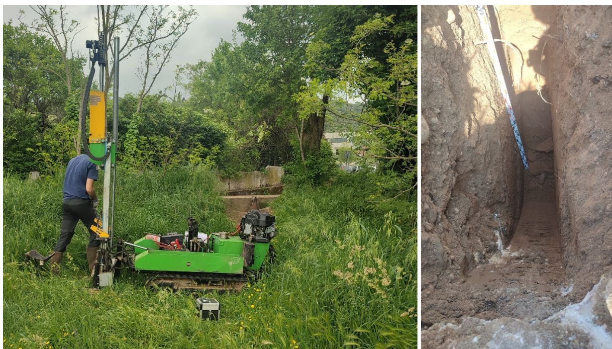
Figura 17: Indagini geotecniche: a sinistra penetrometro dinamico, a destra trincea esplorativa dello scavo geognostico.
