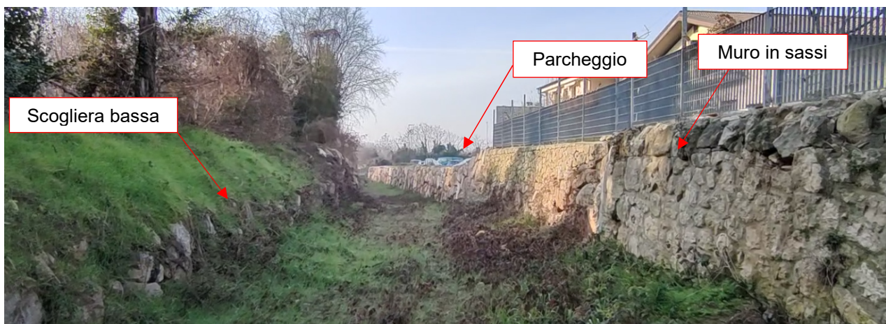
Figura 15: Argini a monte del parcheggio di via della Consortia
