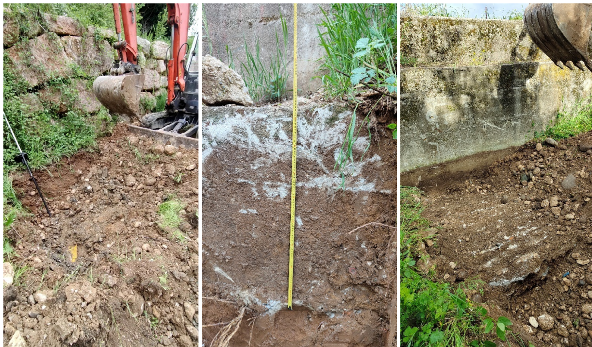
Figura 18: Saggi per la verifica della tipologia e della profondità delle fondazioni dei muri spondali.
